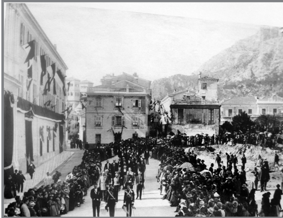
■ 1889 Obsèques du Prince Charles III avc à droite les travaux démolition du «Désert» (APP.)
